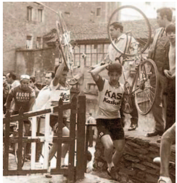
Subida a Arrate distintos años. Paso a nivel de Legarre
